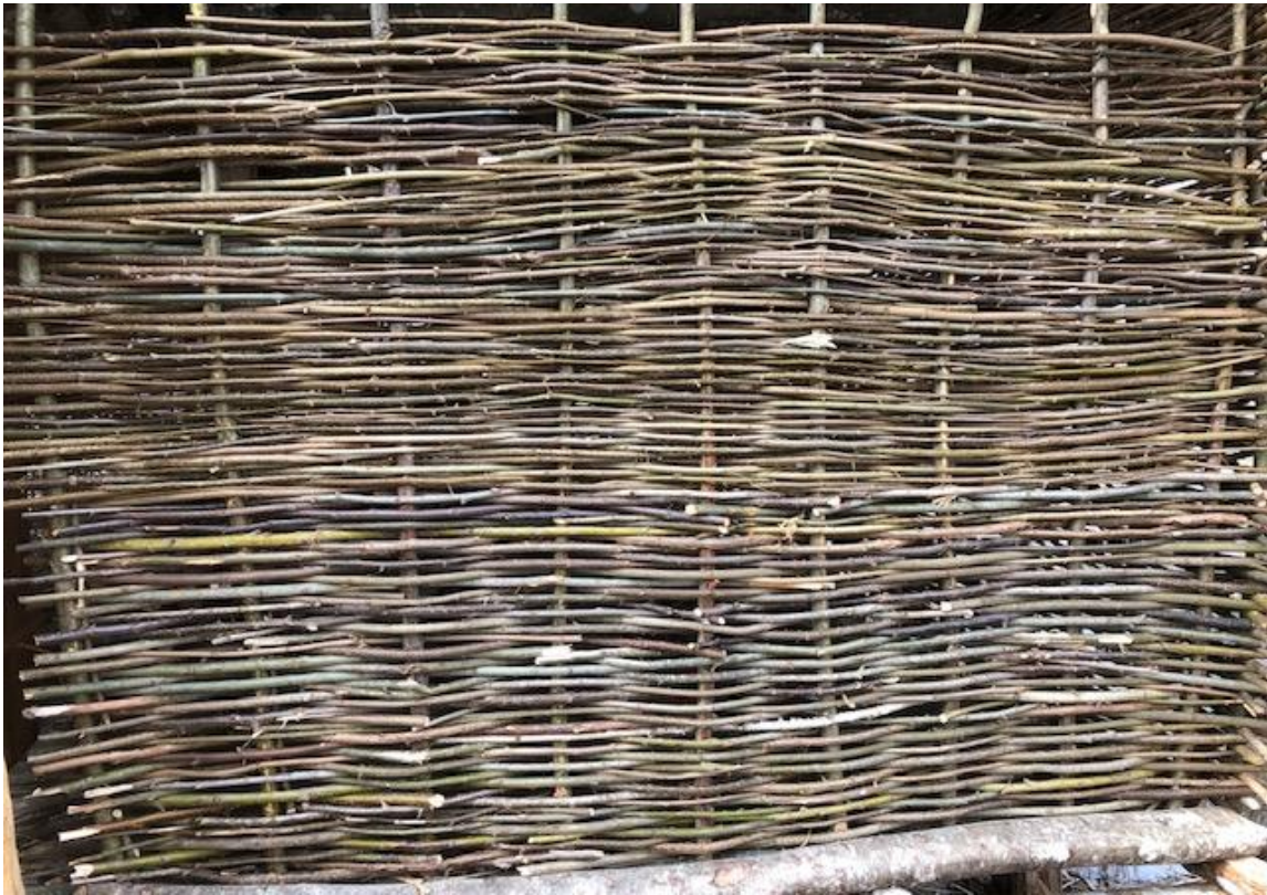
So sieht eine geflochtene Wand im Detail aus
