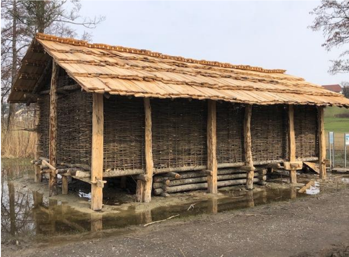
So sieht eine geflochtene Wand im Detail aus
