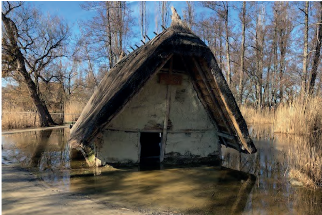
Das alte Pfahlbauhaus war nicht mehr zu retten und musste abgerissen werden.
